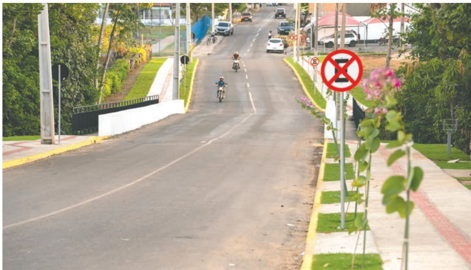
Paisagismo e calçadas em ponte
