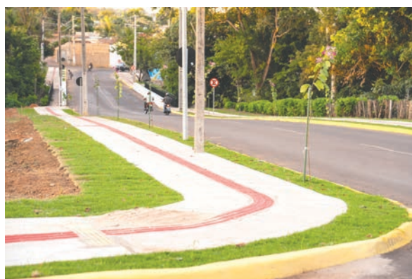
Paisagismo e calçadas em ponte
